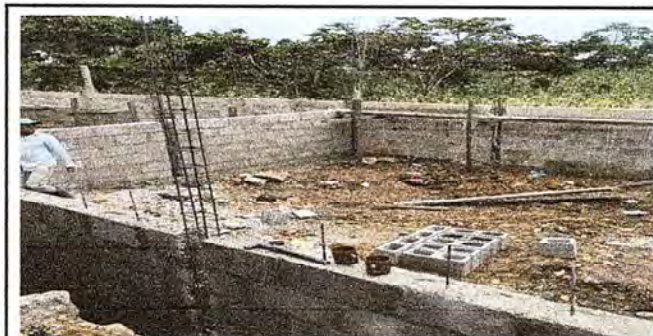
Foto 5: Aprovechamiento de la pared perimetral para la construcción de un aula.
