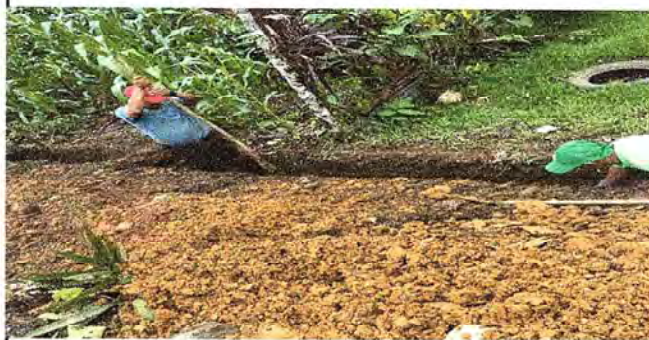
Foto 2: Excavación del cimiento de la circulación del predio del establecimiento.
