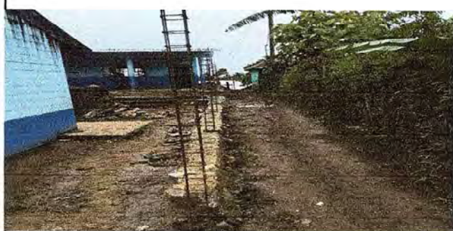
Foto 3: Cimiento de piedra de la circulación del predio del establecimiento.
